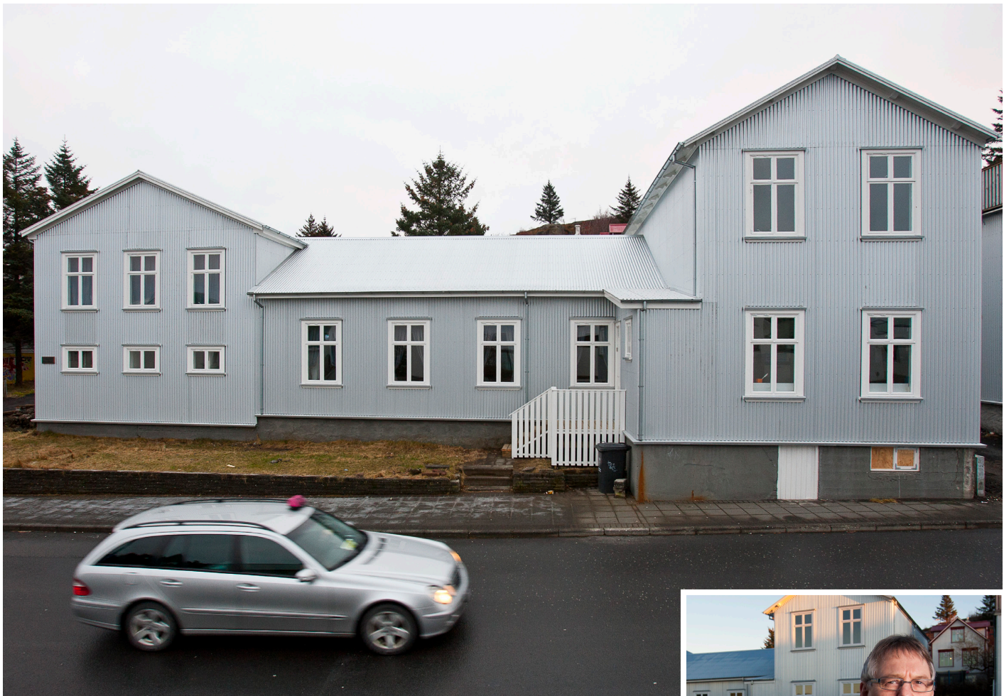
Gúttó er talið vera elsta samkomuhús landsins og eitt besta dæmið um íslenskt landsbyggðarleikhús á fyrri hluta síðustu aldar.
